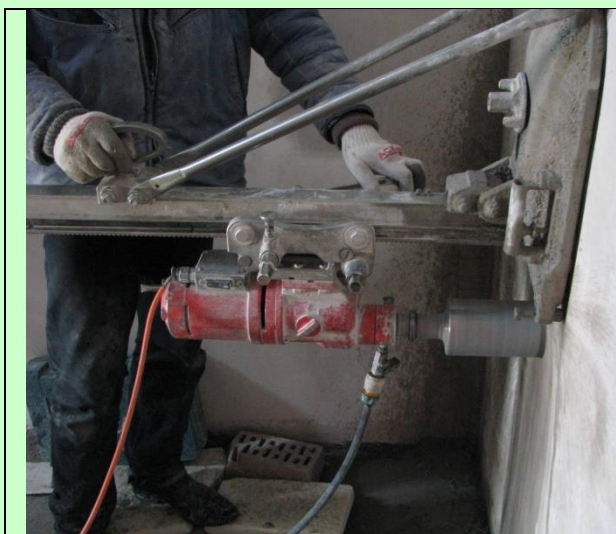
Рисунок 1. Выбуривание керна.
